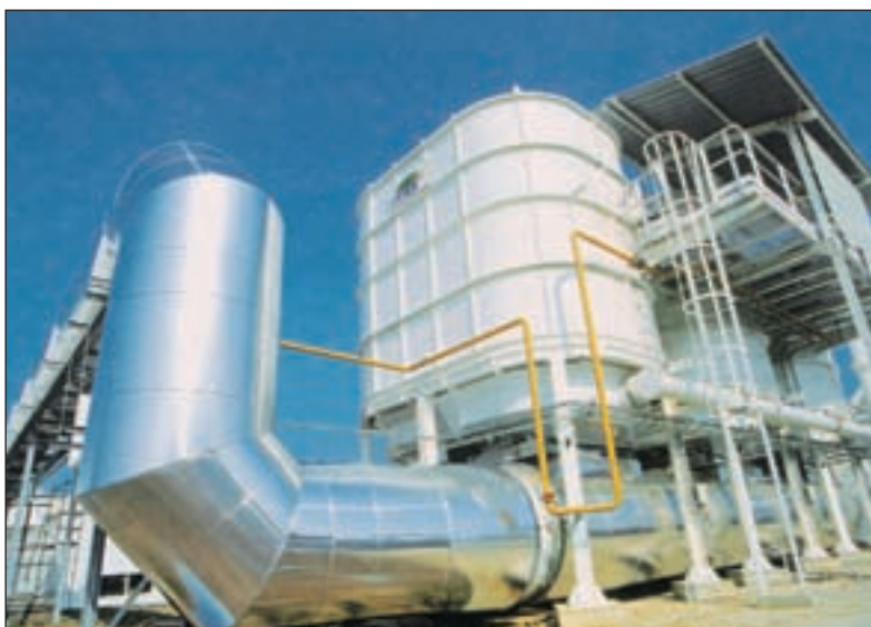
Fig. 3 - Il sistema "Flameless" è impiegato da Itas anche sugli impianti di postcombustione rigenerativi "Rigetherm".
