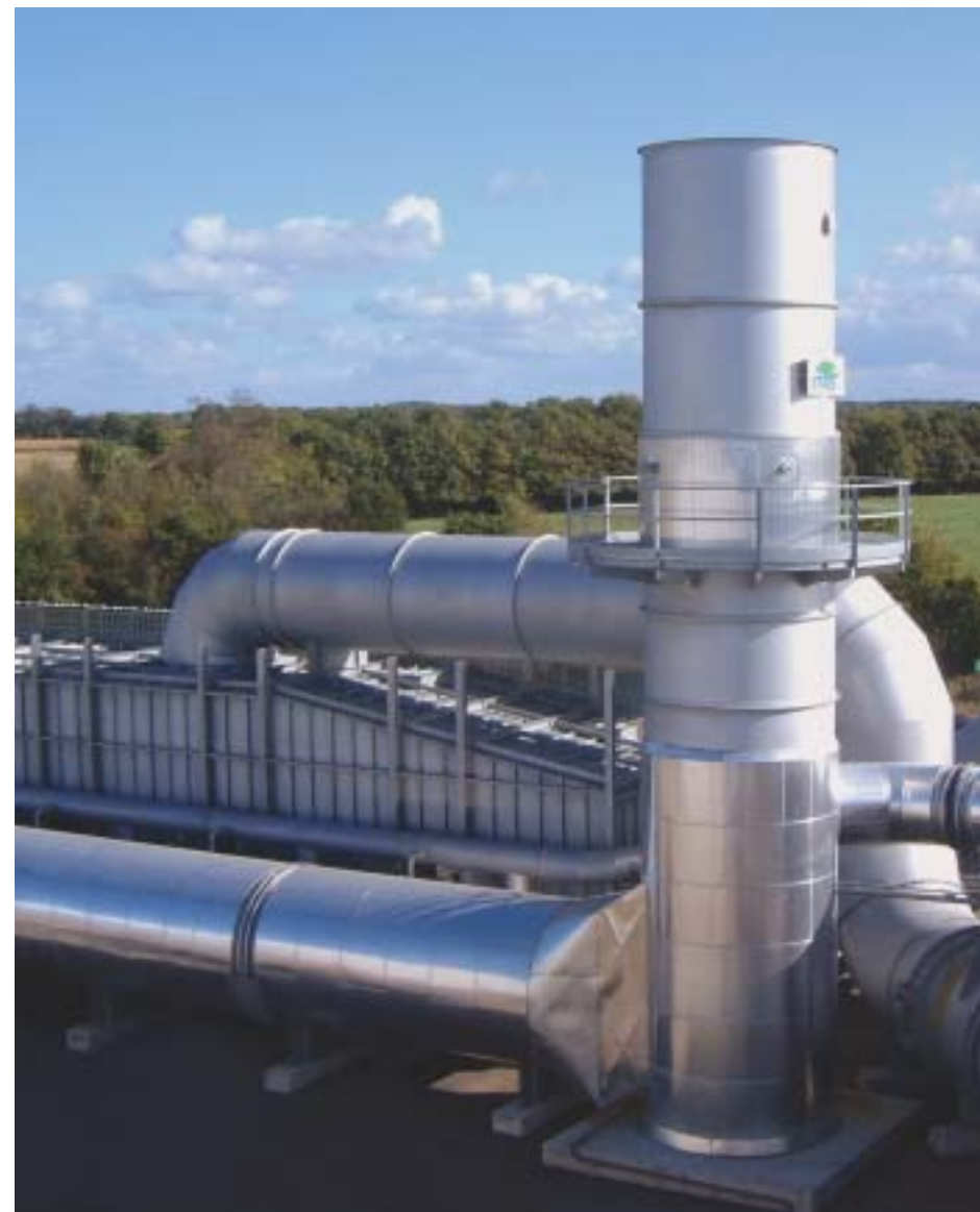
Vista parziale del post-combustore Rigetherm® (con sistema di recupero della caldaia a vapore), cabina di insonorizzazione con locali, quadri e ventilatore di processo.
