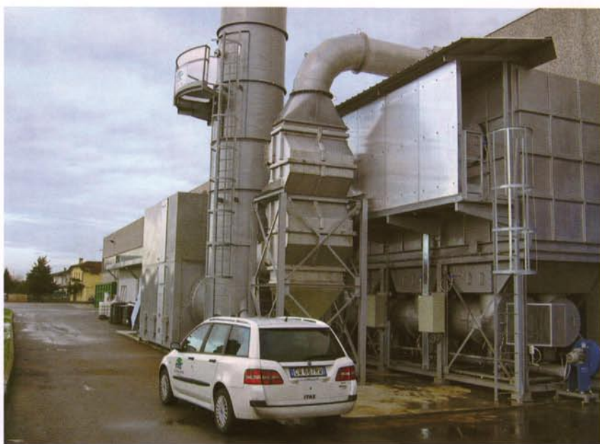
Rotoconcentratore con RTO RIGETHERM® completo di recupero calore e funzionamento autotermico
