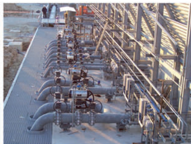
Sistema di regolazione della torcia a terra multi stadio
